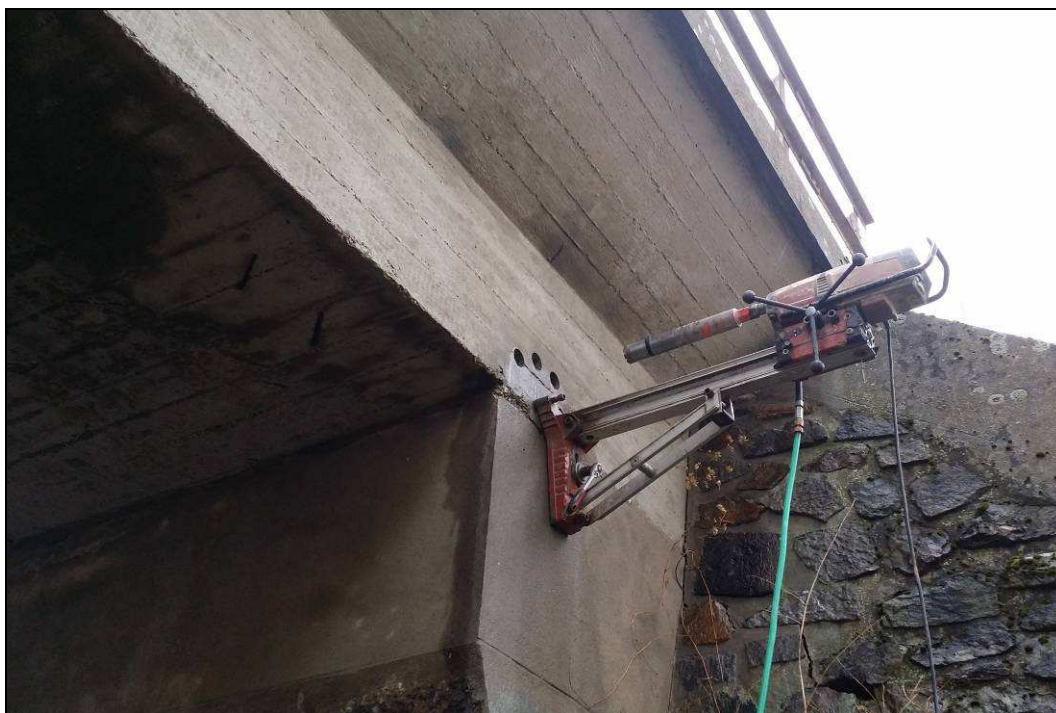
Obr. č. 7 - pohled na místo odběru vzorků pro stanovení pevnosti betonu v tahu - nosná konstrukce nad opěrou Nový Malín
