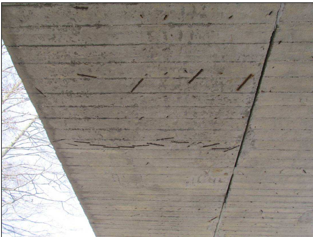
Obr. č. 6 - pohled na spodní líc nosné konstrukce - obnažená konstrukční výztuž napadená povrchovou korozí
